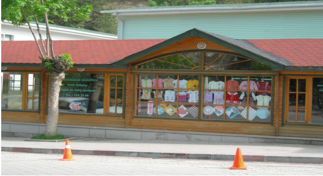
Şekil 9: Kızılcahamam Belediyesi Yerel Ürünler Teşhir ve Satış Merkezi (Küçük, 2011).
