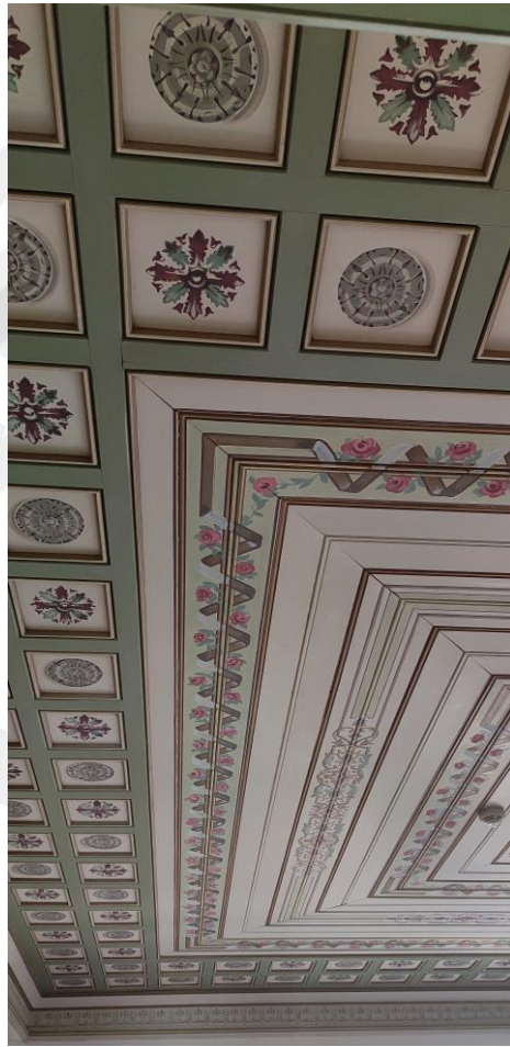
Görsel 132. Üçüncü kat Sofanın Ata Sokak (Sağ) tarafında kalan odanın tavanın da uygulanan kalem işi işleminin görseli (Fotoğraf: Sadık Çağrı Bildiş, 2022).
