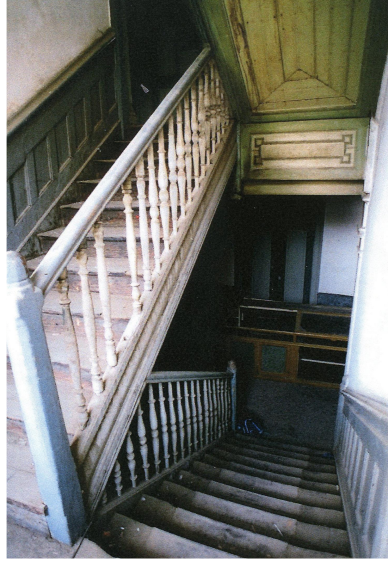
Görsel 75. M3 merdivenlerinin restorasyon öncesi görünümü (Yapı Merkezi Arşivi).
