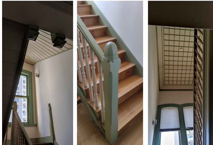
Görsel 82. M4 merdivenlerinin ve merdiven kovasının tavanına ait görsel (Fotoğraf: Sadık Çağrı Bildiş, 2022).
