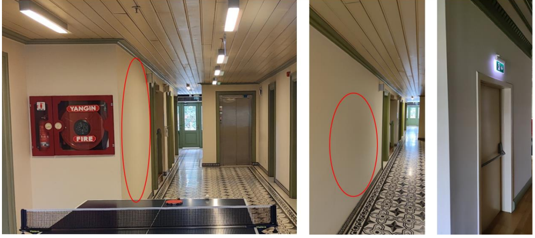
Görsel 79. M4 merdivenlerinin zemin katta iptal edilen çıkışı ve birinci katta yer alan yangın merdiveninin kapısı fotoğrafları (Fotoğraf: Sadık Çağrı Bildiş, 2022).
