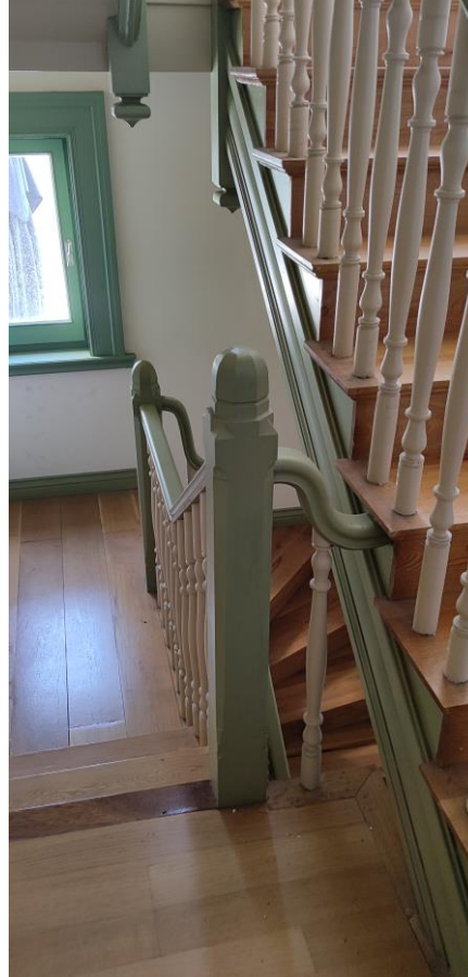
Görsel 80. M4 merdivenlerinin restorasyon sonrası görünümü (Fotoğraf: Sadık Çağrı Bildiş, 2022).
