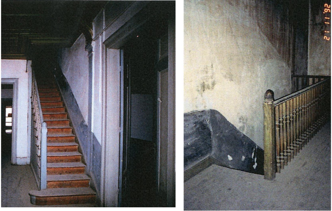
Görsel 83. M5 merdivenlerinin restorasyon öncesinde çekilmiş fotoğrafları (Yapı Merkezi Arşivi).
