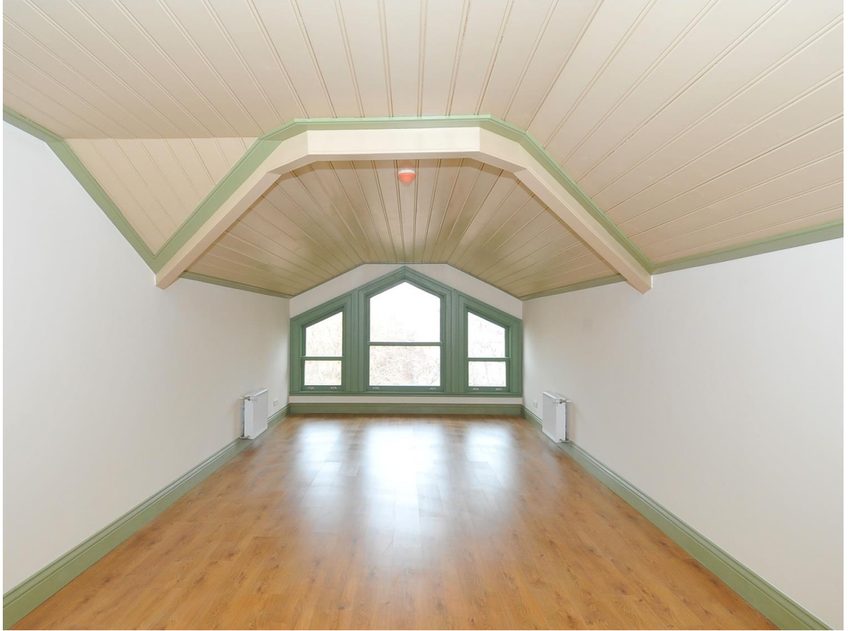
Görsel 99. Çatı katı duvarlarının yenileme çalışması sonrası görseli ((Araltık 2013 Restorasyon Raporu).
