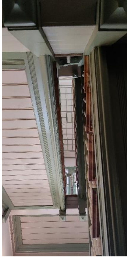
Görsel 74. M3 merdivenlerinin taban ve merdiven kovası tavan görünümü (Fotoğraf: Sadık Çağrı Bildiş, 2022).
