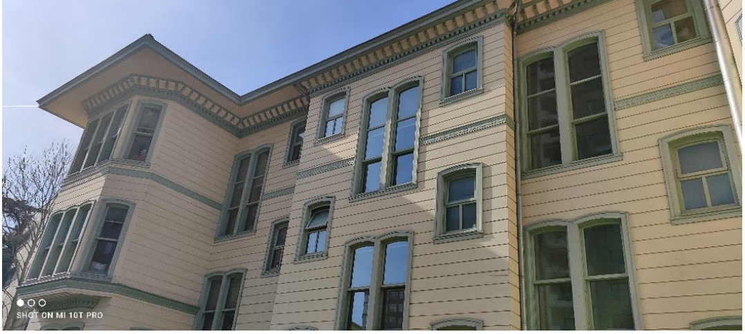
Görsel 42. Doğu cephesinde bulunan çıkımların görseli (Fotoğraf: Sadık Çağrı Bildiş, 2022).
