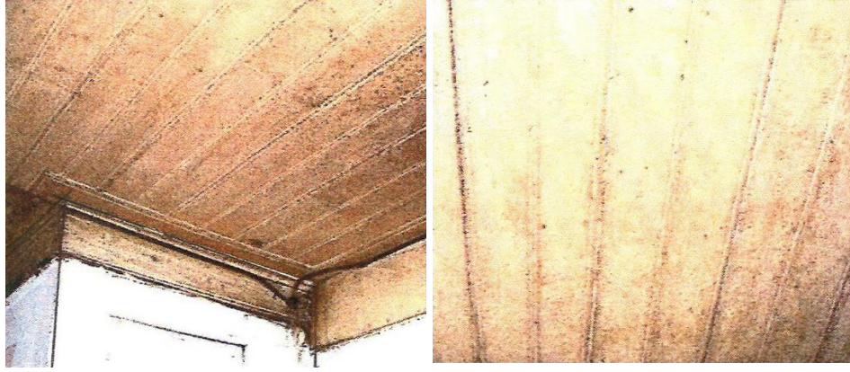
Görsel 102. Zemin katta yer alan düz tavan örneklerinin restorasyon öncesine ait görselleri (Yapı Merkezi Arşivi).
