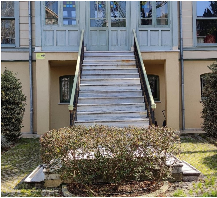
Görsel 40. Batı cephesi M1 merdivenleri (Fotoğraf: Sadık Çağrı Bildiş, 2022).
