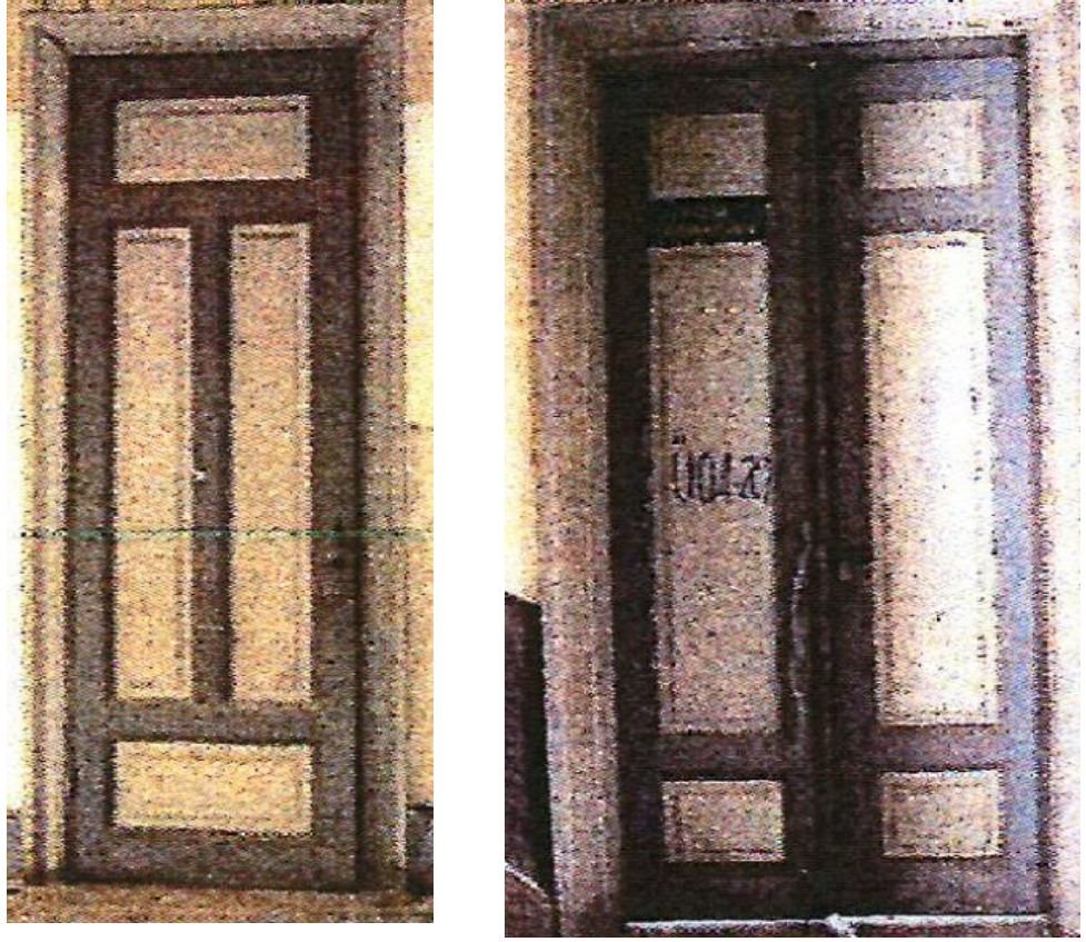
Görsel 61. Köşkün restorasyon öncesinde kapıların görselleri sol baş tek kanat ve çift kanat kapı örnekleri (Yapı Merkezi Arşivi).
