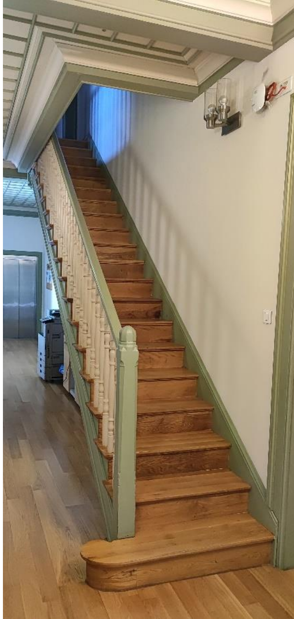
Görsel 84. M5 merdivenlerinin restorasyon sonrası fotoğrafı (Fotoğraf: Sadık Çağrı Bildiş, 2022).
