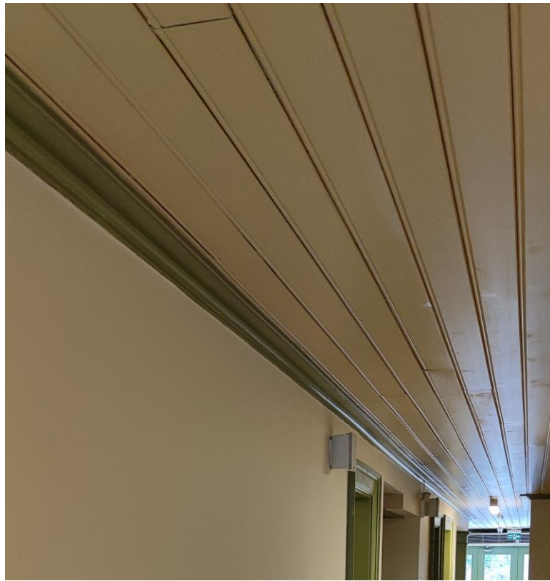
Görsel 103. Zemin kat holünde bulunan düz tavan örneğinin restorasyon sonrasına ait görseli (Fotoğraf: Sadık Çağrı Bildiş, 2022).
