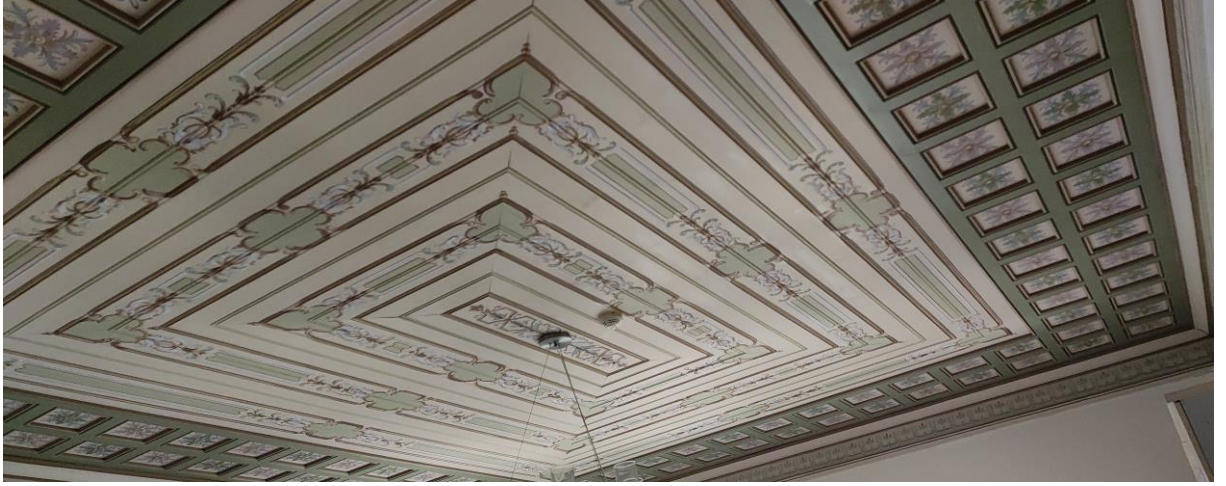
Görsel 130. Üçüncü kat Sofanın Umut Sokak (Sol) tarafında kalan odanın tavan işi işleminin görseli (Fotoğraf: Sadık Çağrı Bildiş, 2022).
