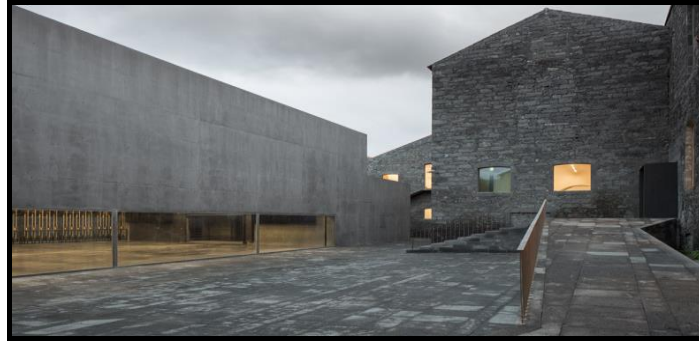
Resim 9. Arquipelago Çağdaş Sanat Merkezi Eski-Yeni Uyumu, (24 Ağustos 2016 tarihinde http://www.dezeen.com/2015/02/11/arquipelago-contemporary-arts-centre-menos-e-mais-arquitectos-joao-mendes-ribeiro/ adresinden alınmıştır.)
