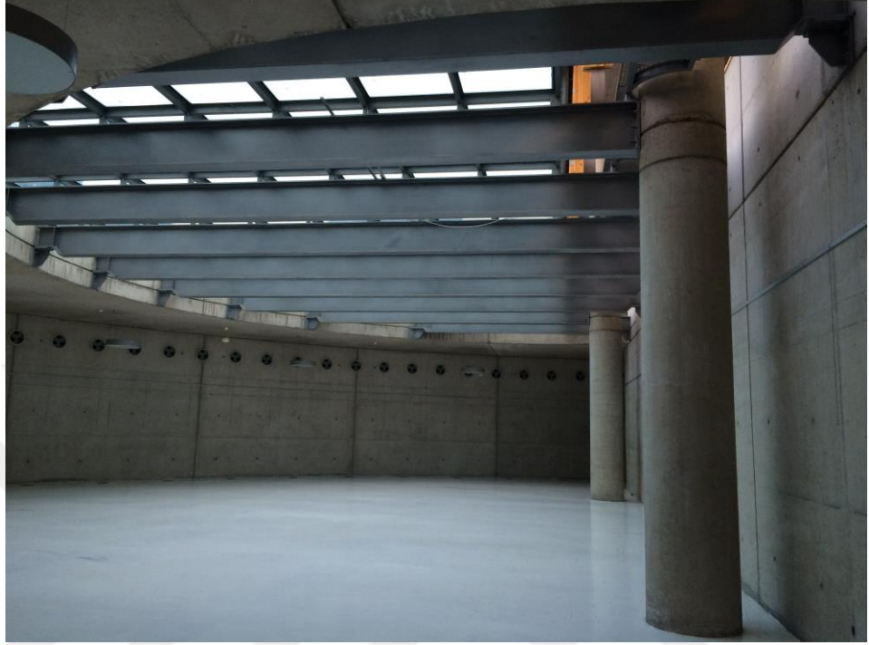
Resim 85. Cer Modern, Ek Yapı, Bodrum Kat, Geçici Sergi Alanı, Tepe Işıklığı Çelik Profiller (Fotoğraf: Rengin Seren, Aralık 2015)
