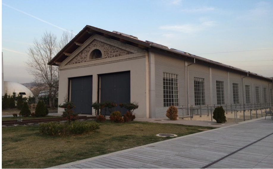
Resim 46. Cer Modern, C hangarı-Galeri 4, Galeri 4 oluklu metal saç dış cephe kaplaması (Fotoğraf: Rengin Seren, Aralık 2015)
