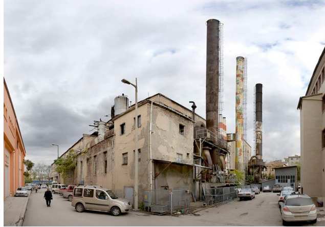
Resim 21. Tarihi Maltepe Havagazı Fabrikası, yıkılmadan önce (24 Ağustos 2016 tarihinde http://www.goethe.de/ins/tr/ank/prj/urs/geb/ind/gas/trindex.htm adresinden alınmıştır.)
