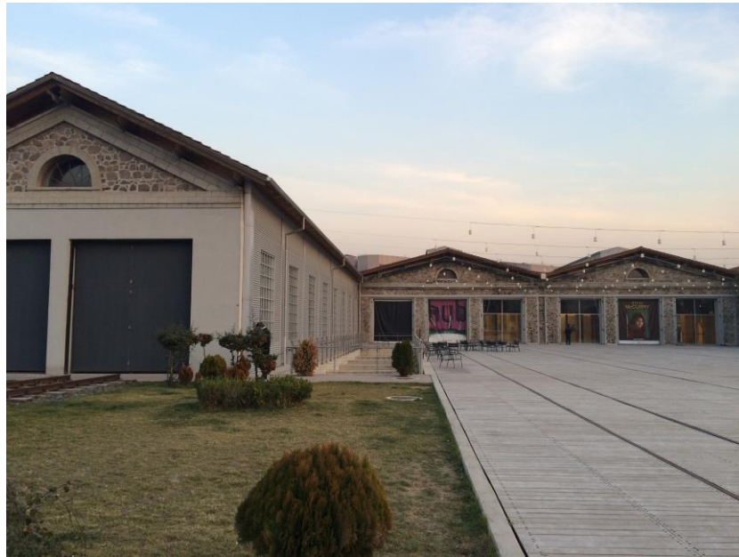
Resim 42. Cer Modern, Galeri 2,3,4 – C, D, E Hangarları, Yeniden İşlevlendirme Hangar Kapılarının Son Hali (Fotoğraf: Rengin Seren, Aralık 2015)
