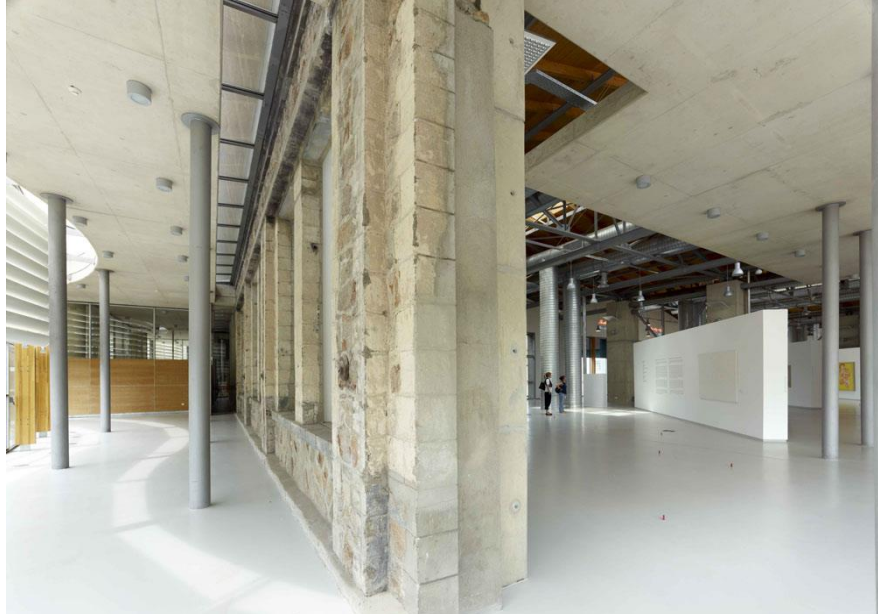
Resim 79. Cer Modern, Yeni Yapı ve Hangarların İlişkisi, Yeniden İşlevlendirme Sonrası (09 Kasım 2016 Tarihinde http://www.arkiv.com.tr/proje/cer-modern/1535 adresinden alınmıştır.)
