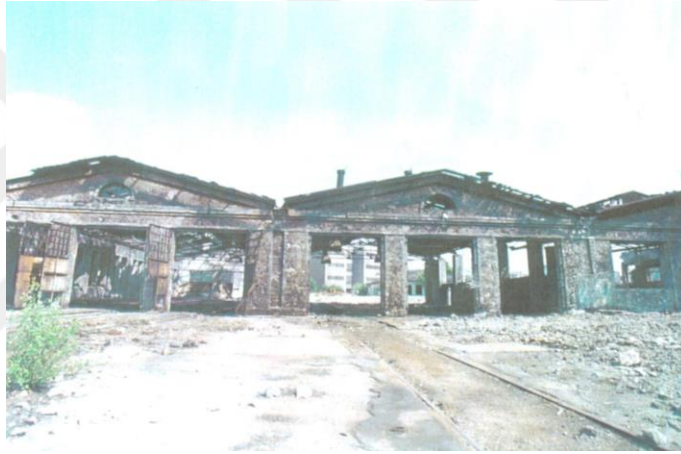
Resim 49. Cer Atölyeleri, Avlu – Hangarların önündeki raylar, Yeniden İşlevlendirme Öncesi (Kaynak: Uygur Mimarlık, Şubat 2000)
