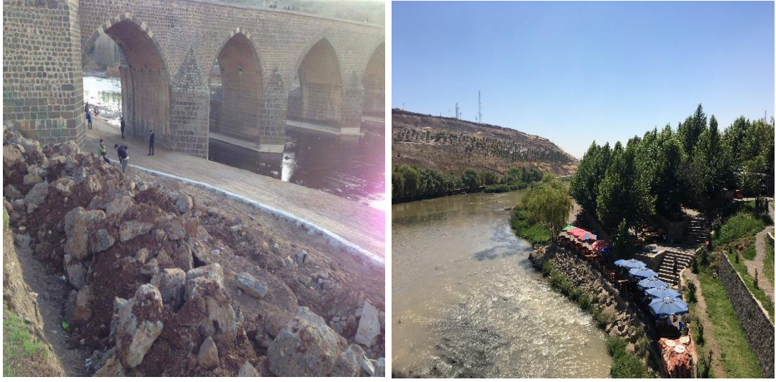
Şekil 4. 51 Dicle Vadisi, On Gözlü Köprü Kır Bahçesi, 2018 [162], [163]
