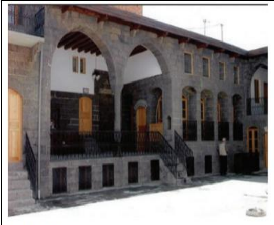
Şekil 7. Yapının restorasyon sonrası güney cephesi
