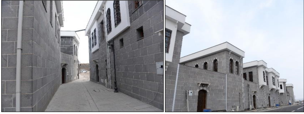
Şekil 4. 54 Yeni İnşa Edilen Evler, Hasırlı Mahallesi
