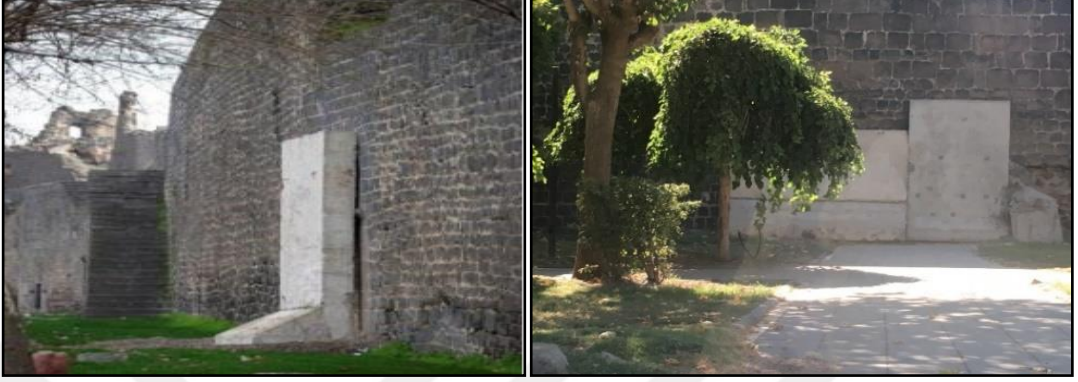
Şekil 4. 34 Diyarbakır Surları, Burçlar Arasına İnşa Edilen Beton Bloklar [118: 25], [126]
