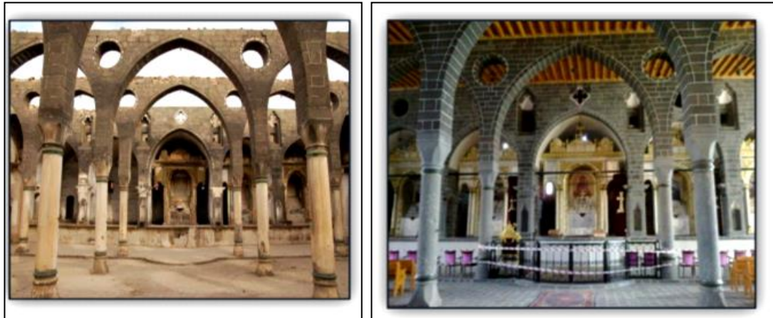
Şekil 4. 30 Surp Giragos Kilisesi, Restorasyon Öncesi ve Sonrası [118]
