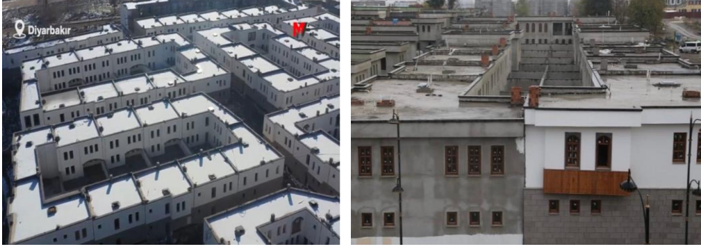
Şekil 4. 57 İnşa Edilen Yeni Evler [170], [171]
