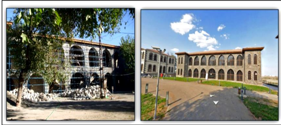
Şekil 4. 26 İçkale Restorasyon Sonrası [118]
