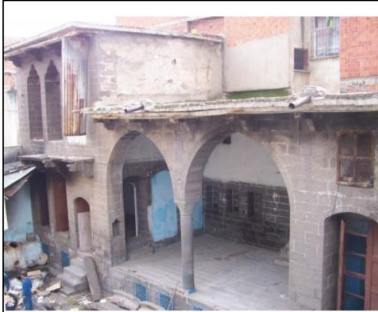
Şekil 5. Yapının restorasyon öncesi güney cephesi
