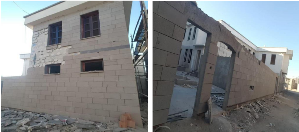
Şekil 4. 56 İnşa Edilen Yeni Evler
