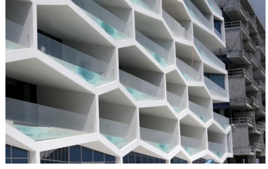
Şekil 76: Honeycomb - Albany Marina Rezidans Balkonları Cephe Görüntüsü, Bahama Milletler Topluluğu (URL 70)
