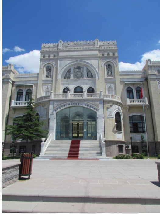
Resim 25: Ankara Resim Heykel Müzesi / Eski Türk Ocağı Binası'nın Ön Cephe Girişi.
