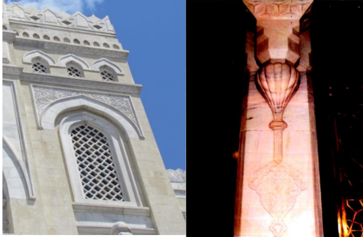
Resim 40: Eski Türk Ocağı Binası'nın ön cephe pencere ve saçak çevresi süslemelerinden bir ayrıntı ve (sağda) ön cephe ana girişindeki bronz kapılar arasındaki mermer süslemeleri.
