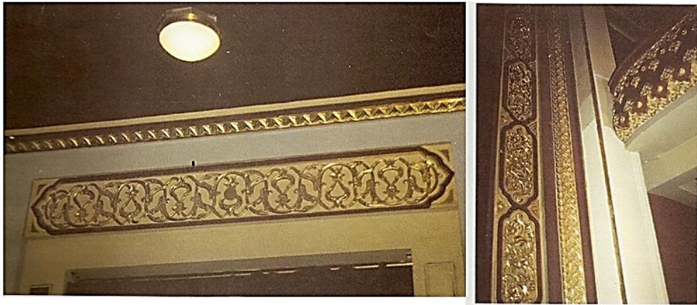
Resim 44: Eski Türk Ocağı Binası'nın tiyatro salonundaki alçı ve yıldız süslemeler.
