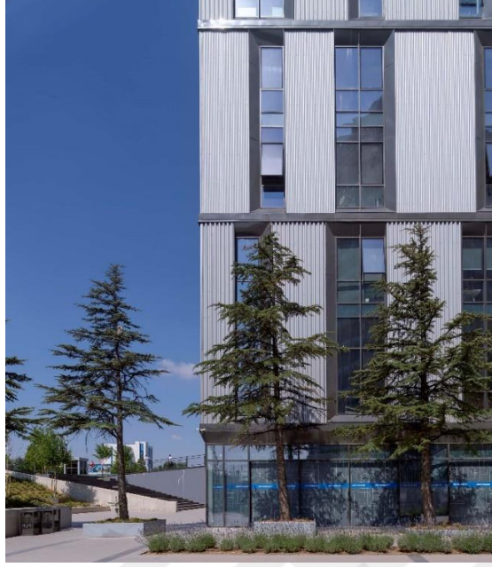
Şekil 4.15 ODTÜ TEKNOKENT Bilişim ve İnovasyon Merkezi cephesinde kullanılan dikey metal elemanlar
