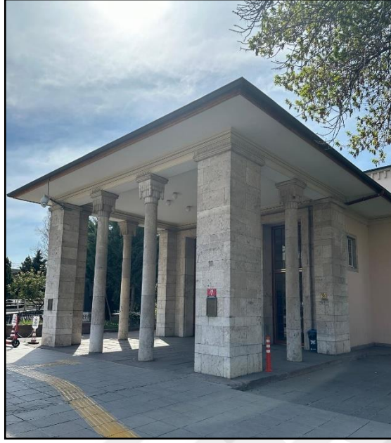
Şekil 5.51 Devlet Opera ve Bale Binası giriş cephesinde oluşan arayüz, 23 Mart 2024 Kaynak: Esra Kıratlı Kişisel Arşivi
