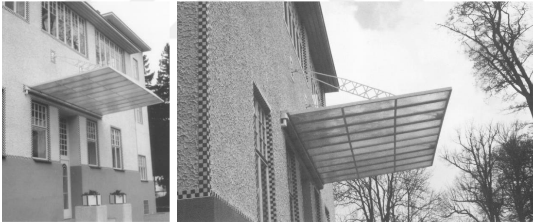
Şekil 5.47 Kanopi, Doğu Cephe (1995 Restorasyonu Sonrası) (Topp, 1997, 431–432)
