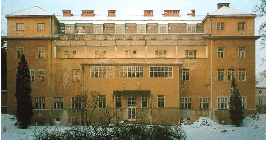
Şekil 5.50 Bauer'ın Eklemesinden Sonra Doğu Cephesi (Purkersdorf-Online, 2020)
