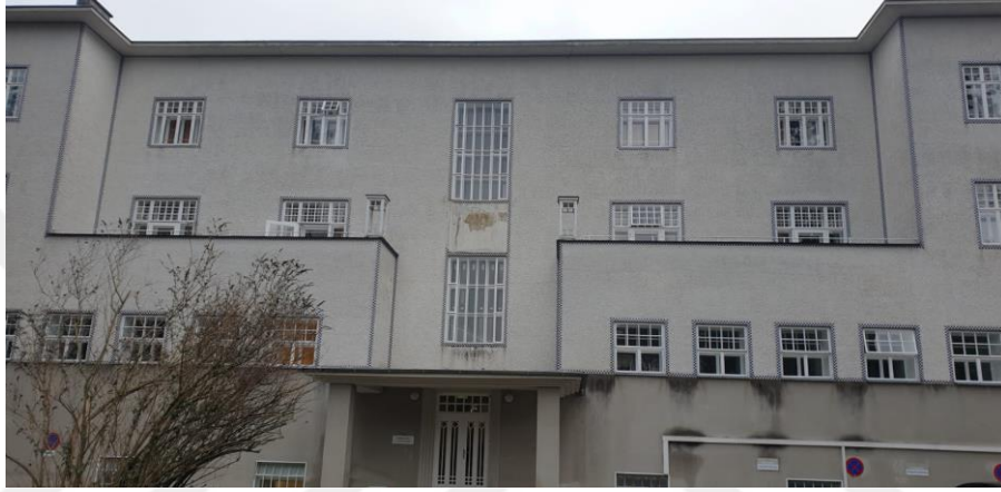
Şekil 5.56 Batı Cephesi, 2022 (Pfeiffer-Taş, 2022)
