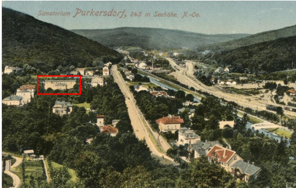
Şekil 5.12 Purkersdorf Sanatoryumu, 1911 (Österreichische Nationalbibliothek-AKON, 2015a)
