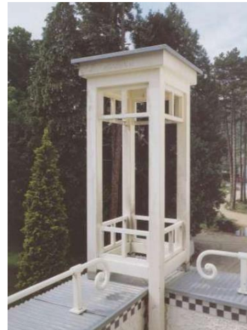
Şekil 5.62 Batı Cephesindeki Ahşap Fener Detayı (Thun-Hohenstein, 2012, 184)
