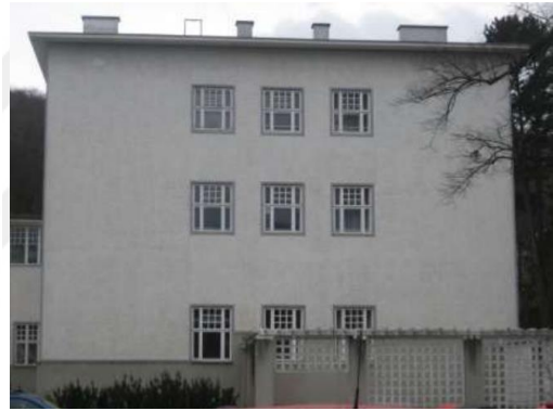
Şekil 5.64 Kuzey Cephesi, 2012 (Thun-Hohenstein, 2012, 177)
