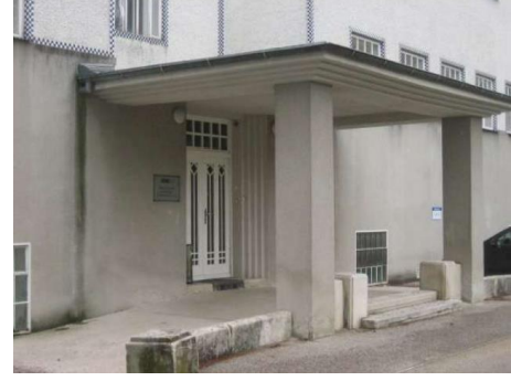
Şekil 5.58 Eski Boyutuna Getirilen Yükseltmiş Zemin Kat Pencereleeri, Batı Cephe, 2012 (Thun-Hohenstein, 2012, 180)
