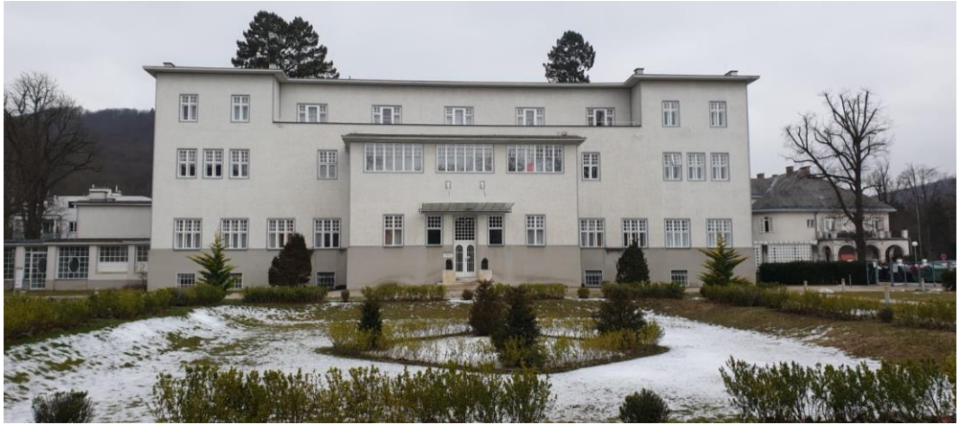
Şekil 5.51 Doğu Cephesi, 2022 (Pfeiffer-Taş, 2022)
