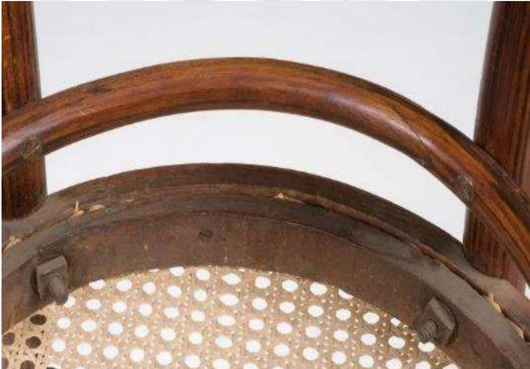
Resim 41. Thonet No:14 ayak bağlantı detayı. (URL 15)
