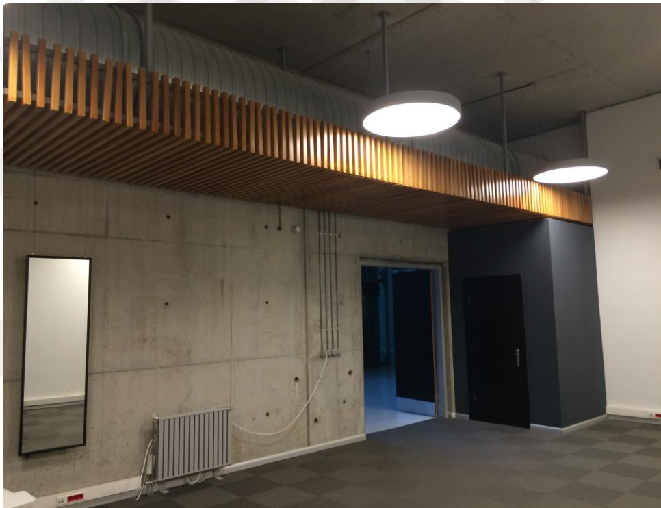
Resim 84. Cer Modern, Ek Yapı, Bodrum Kat, Atölye (Fotoğraf: Rengin Seren, Aralık 2015)
