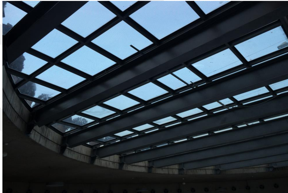
Resim 86. Cer Modern, Ek Yapı, Bodrum Kat, Geçici Sergi Alanı, Tepe Işıklığı Çelik Profiller (Fotoğraf: Rengin Seren, Aralık 2015)
