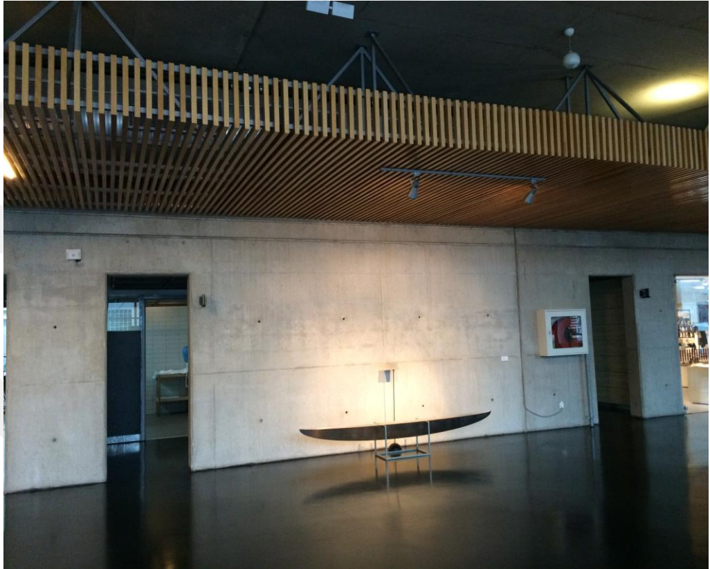
Resim 80. Cer Modern, Ek Yapı, Karşılama Alanı, asma tavan (Fotoğraf: Rengin Seren, Aralık 2015)
