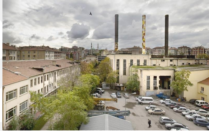
Resim 20. Tarihi Maltepe Havagazı Fabrikası, yıkılmadan önce (24 Ağustos 2016 tarihinde http://www.goethe.de/ins/tr/ank/prj/urs/geb/ind/gas/trindex.htm adresinden alınmıştır.)
