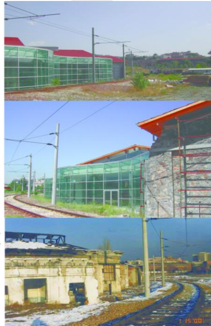
Resim 55. Cer Atölyeleri- Cer Modern, Yeniden İşlevlendirme Öncesi ve Sonrası Yeni Yapı Uyumu (Kaynak: Uygur Mimarlık, řubat 2000)
