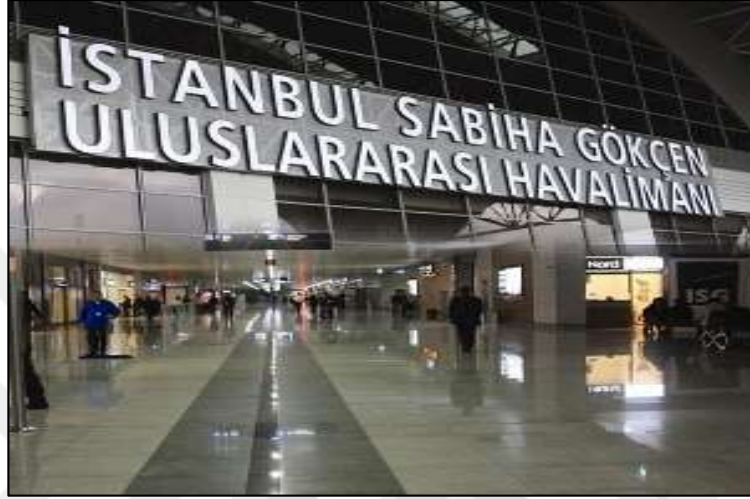
Resim 1.2.5.1. İnsan geçişinin yoğun olduğu havaalanı terminal binası yer kaplamasında kullanılan sert taşlardan mermer örneği (İstanbul Sabiha Gökçen Uluslararası Havalimanı)
