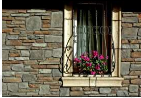
Resim 1.2.2.1 Taşın yapıda kaplama olarak kullanımına örnek
