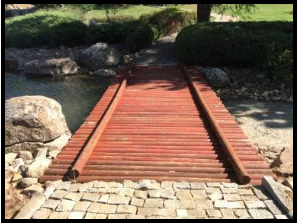
Şekil 53 Japon Bahçesi Köprü Görünüşü (Orijinal,2014)
