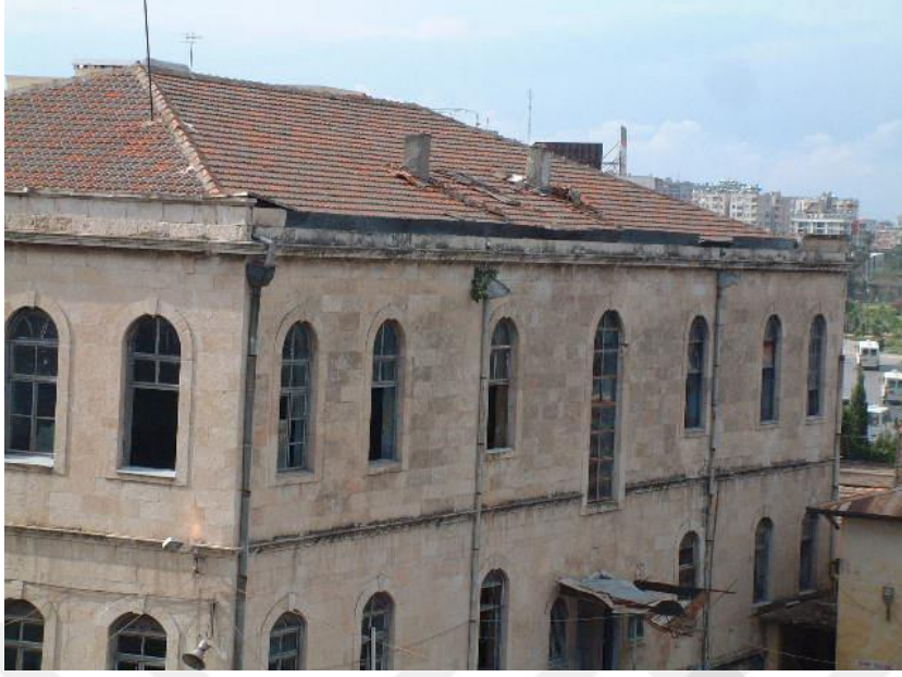
Resim 32. Adana Kız Lisesi Dönemi, Doğu Cephesi, 1998 (Belkıs Yakıcı Fotoğraf Albümü, 2018 )
