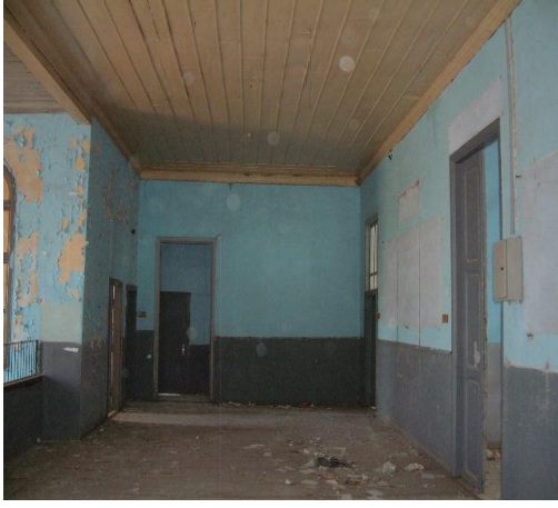
Resim 101. Adana Kız Lisesi Dönemi, 1. Kat Hol- Güney Yönü Restorasyon Öncesi
