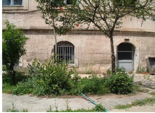
Resim 37. Adana Kız Lisesi Dönemi Güney Cephesi Bodrum III. Penceresinin Kapıya Dönüşüm
