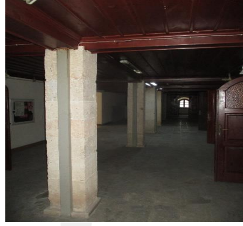
Resim 60. Adana Kız Lisesi, Bodrum Kat Kolonları Güçlendirme, Restorasyon Sonrası Ila. (Fotoğraf: Şükriye Sıla Özdemir, 2020).
