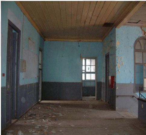
Resim 99. Adana Kız Lisesi Restorasyon Öncesi Birinci Kat Hol- Kuzey Yönü
