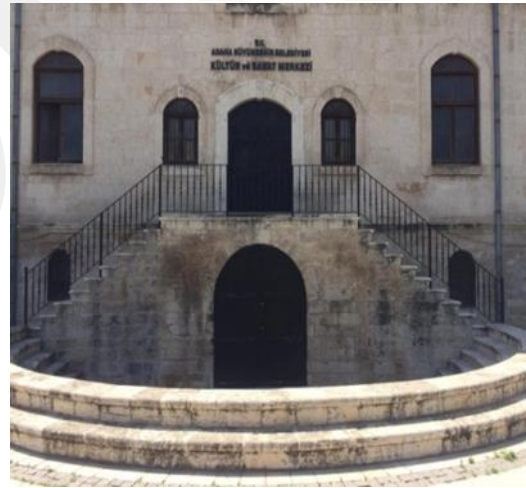
Resim 34. Adana Kız Lisesi, Doğu Cephesi, Bodrum Giriş, Restorasyon Sonrası. (Fotoğraf: Şükriye Sıla Özdemir, 2020)
