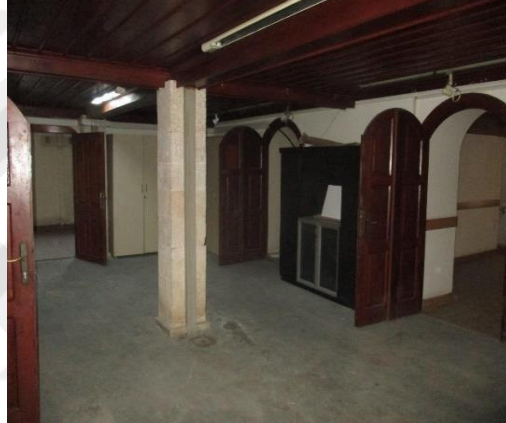
Resim 64. Adana Kültür ve Sanat Merkezi dönemi, Bodrum Kat Kapıları Restorasyon Sonrası (Fotoğraf: Şükriye Sıla Özdemir, 2020)
