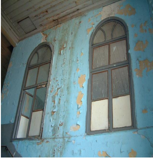
Resim 94. Adana Kız Lisesi, Merdiven Çıkışı Sağ Oda Penceresi Restorasyon Öncesi (Fotoğraf: Mehmet Pekcan Işık, 2004)
