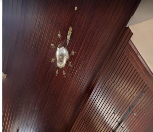
Resim 76. Adana Kùltür ve Sanat Merkezi Zemin Kat Tavan Restorasyon Sonrası (Fotoğraf: Şükriye Sıla Özdemir, 2020)
