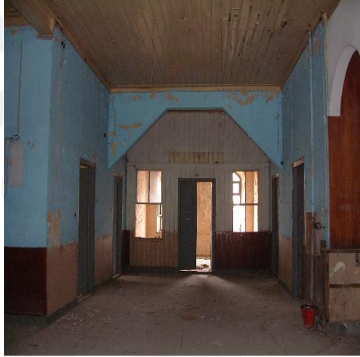
Resim 78. Adana Kız Lisesi, Zemin Kat, Hölin Kuzey Yönü (Sol) Bölünmüş Duvar Restorasyon Öncesi (Fotoğraf: Mehmet Pekcan Işık, 2004)
