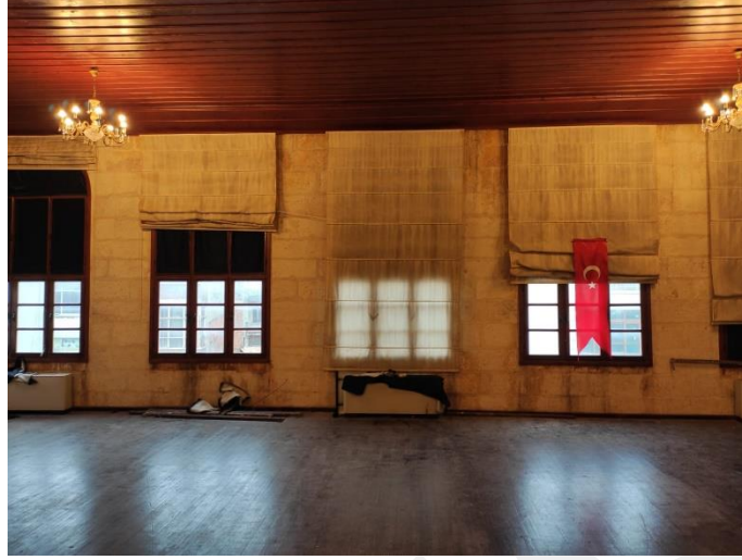
Resim 114. Adana Kültür ve Sanat Merkezi Dönemi Bk03 No.lu Mekanın Çıkma Bölümü Taş Duvar (Fotoğraf: Şükriye Sıla Özdemir, 2020)
