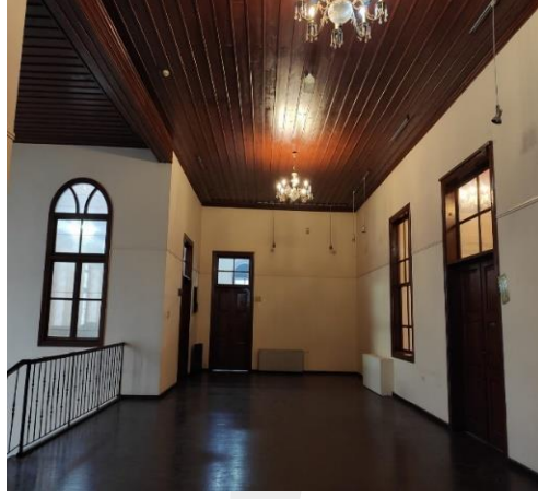
Resim 102. Adana Kültür ve Sanat Merkezi Dönemi, 1.Kat Hol- Güney Yönü, Restorasyon Sonrası
