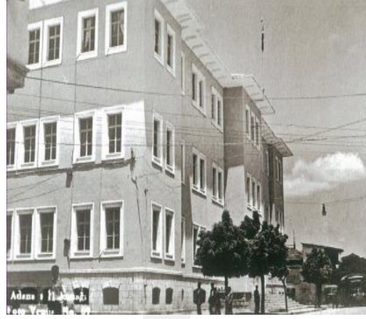
Resim 16. Adana Hükümet Konağı III. Dönem
