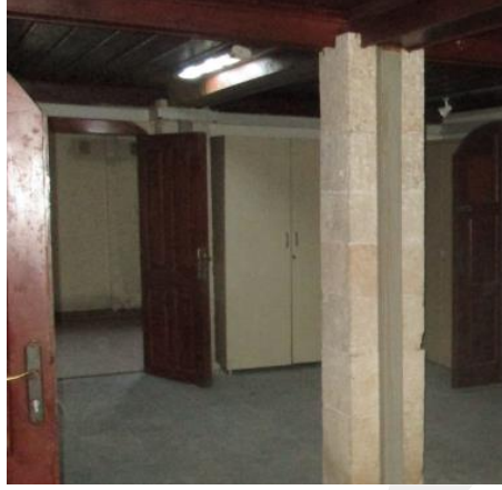
Resim 68. Adana Kız Lisesi, Kùltür ve Sanat Merkezi Dönemi, Bodrum Kat Sonradan Bölünen B08 No.lu Oda Restorasyon Sonrası Müdahale (Fotoğraf: Şükriye Sıla Özdemir, 2020)
