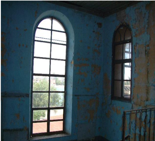
Resim 92. Adana Kız Lisesi Dönemi, Merdiven Penceresi Restorasyon Öncesi
