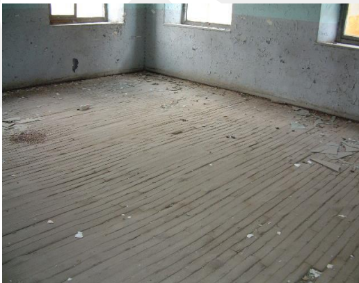
Resim 84. Adana Kız Lisesi Dönemi, Zemin Kat Z03 No.lu Oda Zemin Malzemesi, Restorasyon Öncesi
