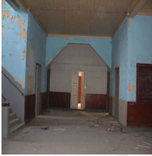
Resim 77. Adana Kız Lisesi Dönemi, Zemin Kat, Hölin Güney Yönü (Sağ) Bölünmüş Duvar Restorasyon Öncesi (Fotoğraf: Mehmet Pekcan Işık, 2004)
