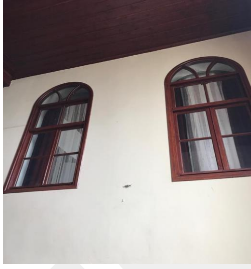
Resim 95. Adana Kültür ve Sanat Merkezi Dönemi Merdiven Boşluğuna Bakan Bk05 No.lu Odanın Pencereleeri (Fotoğraf: Şükriye Sıla Özdemir, 2020)
