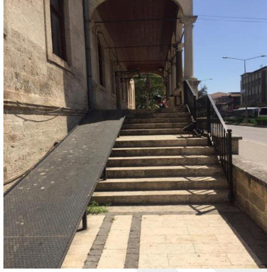
Resim 46. Adana Kız Lisesi Restorasyon Sonrası, Batı Cephesinden Kuzey Yönüne Merdivenlerde Engelli Rampası (Fotoğraf: Şükriye Sıla Özdemir, 2020)
