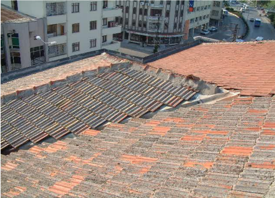
Resim 48. Adana Kız Lisesi Dönemi, Batı Cephesi Çıkma Bölümü Sapma Çatı
