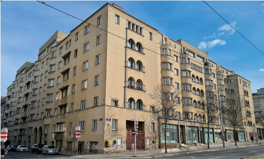
Resim 11. Margaretengürtel ve Brandmayergasse'ye bakan cepheler, çıkma, balkon ve pencere ayrıntı (Şule Pfeiffer Taş kişisel arşivi, 2022)
