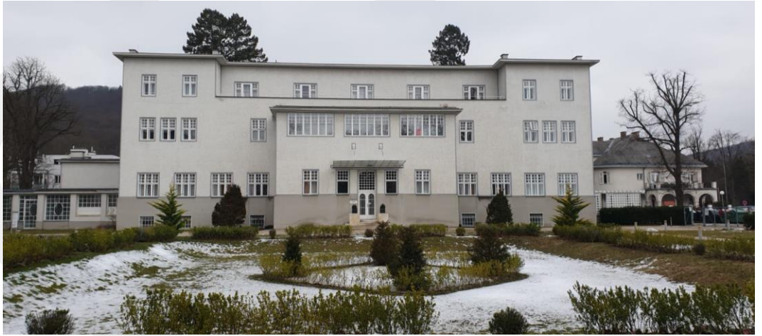
Şekil 5.51 Doğu Cephesi, 2022 (Pfeiffer-Taş, 2022)
