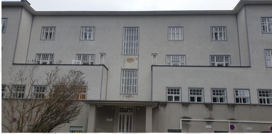
Şekil 5.56 Batı Cephesi, 2022 (Pfeiffer-Taş, 2022)
