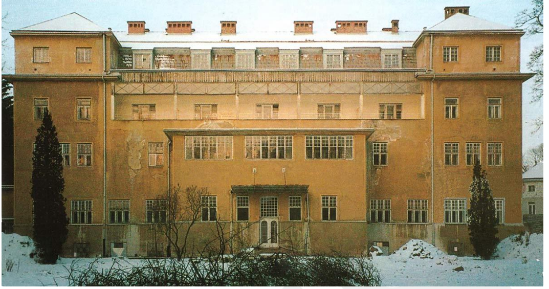
Şekil 5.50 Bauer'ın Eklemesinden Sonra Doğu Cephesi (Purkersdorf-Online, 2020)
