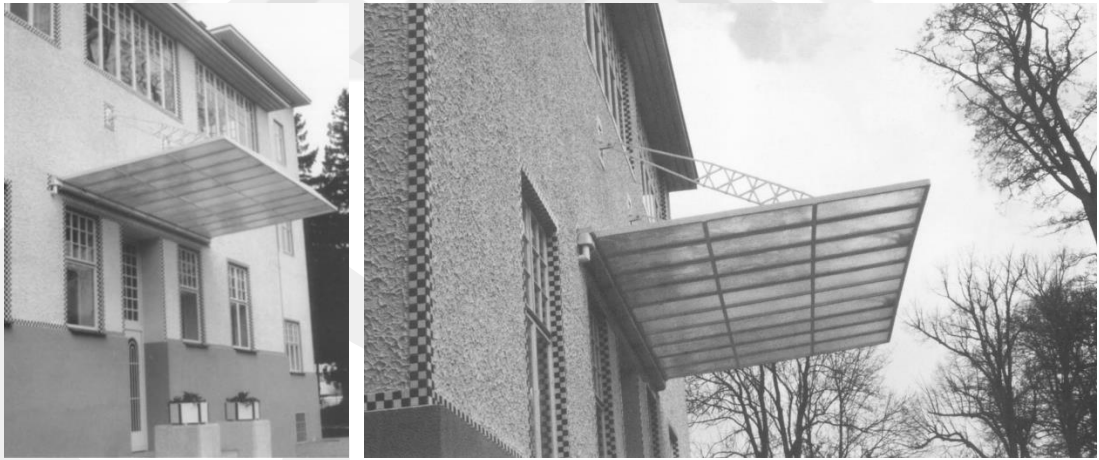
Şekil 5.47 Kanopi, Doğu Cephe (1995 Restorasyonu Sonrası) (Topp, 1997, 431–432)
