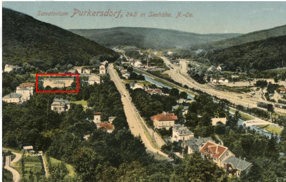
Şekil 5.12 Purkersdorf Sanatoryumu, 1911 (Österreichische Nationalbibliothek-AKON, 2015a)
