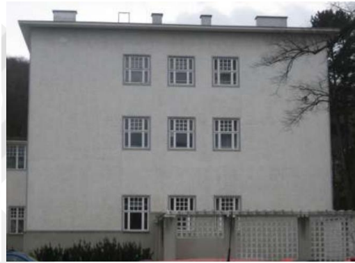
Şekil 5.64 Kuzey Cephesi, 2012 (Thun-Hohenstein, 2012, 177)
