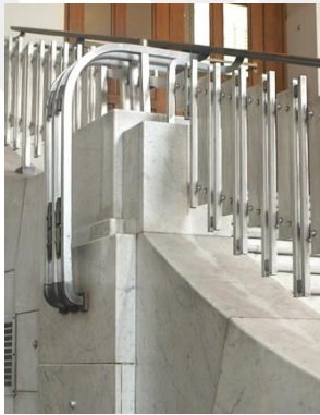
Resim 55. Giriş Holü Merdiveni a) Korkuluk Dış Ayrıntı b) Korkuluk İç Ayrıntı. c) Korkuluk ve Küpeşte Bağlantısı (Rabia Temel, 2019)
