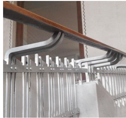
Resim 55. Giriş Holü Merdiveni a) Korkuluk Dış Ayrıntı b) Korkuluk İç Ayrıntı. c) Korkuluk ve Küpeşte Bağlantısı (Rabia Temel, 2019)
