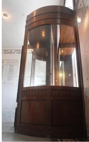
Resim 56. Giriş Bölümü Döner Kapı a) Dış Kapıdan Görünüş b) Dış Gövde Ayrıntı c) Holden Görünüş (Rabia Temel, 2019)
