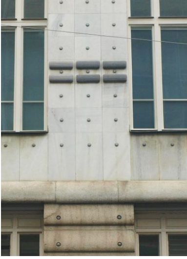
Resim 34. Birinci Kat Cephe Ayrıntı (Rabia Temel, 2019)
