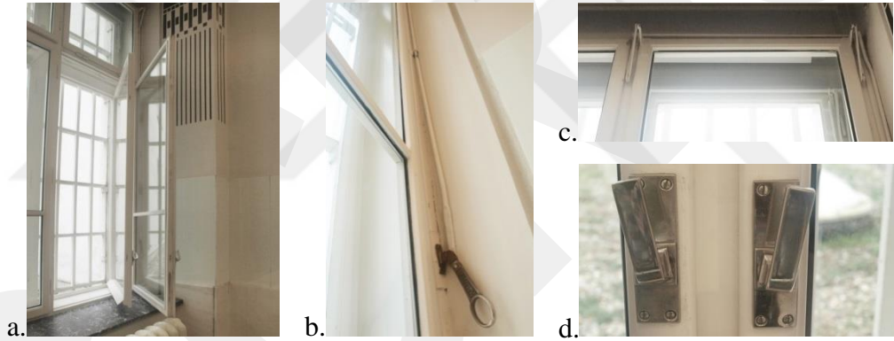
Resim 104. KGS. Pencere a) Genel Görünüm b) Yüksek Pencere Uzun Kol Ayrıtı c) Pencere Kolu d) Yüksek Pencere Uzun Kol Ayrıtı (Rabia Temel, 2019)
