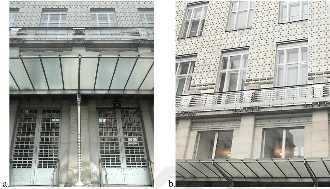
Resim 27. Doğu Cephesi a) Cam Saçak Ayrıntı b) Alüminyum Korkuluk Ayrıntı (Rabia Temel, 2019)
