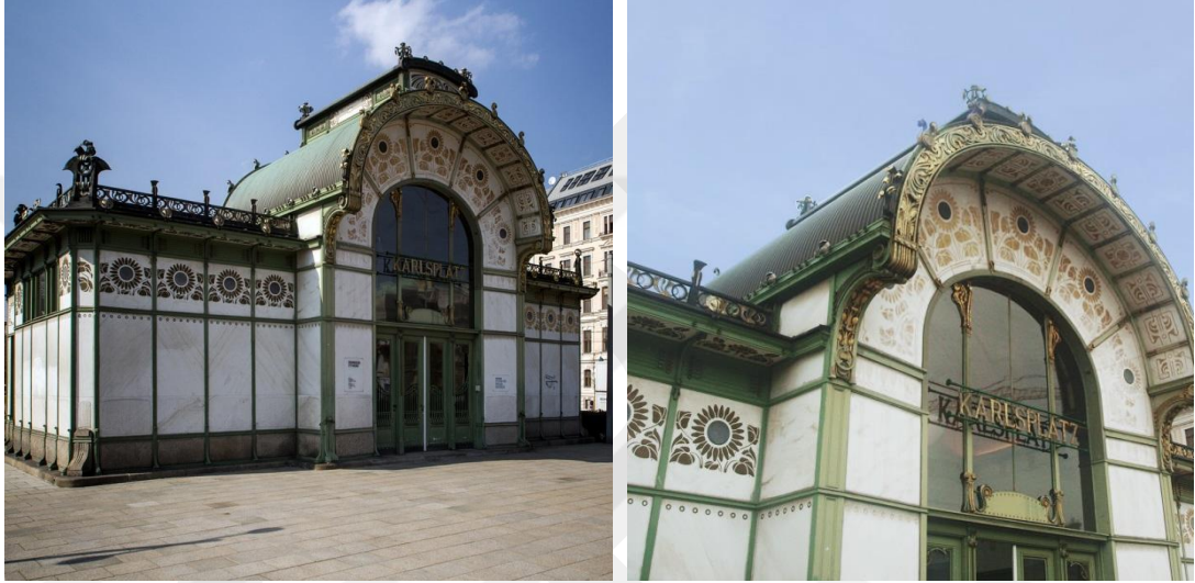
Resim 4. Karlsplatz Metro İstasyonu (Rabia Temel, 2019)
