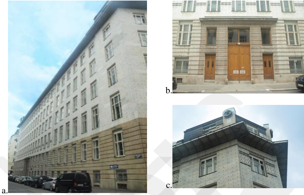
Resim 42. a) Kuzey Cephesi b) Kuzey Cephesi Giriş Kapısı c) Kuzey ve Doğu Cephesi Köşesi Ayrıntı (Rabia Temel, 2019)
