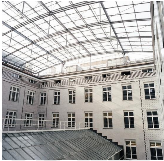
Resim 96. Koruyucu Çatı Genel Görünüm, 2005 (URL 17)
