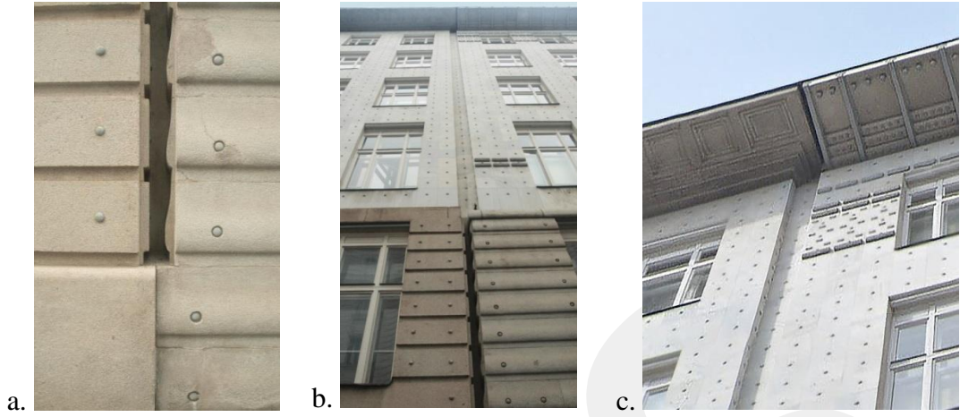
Resim 33. Güney Cephesinde II. ve III. Evrenin Birleşimi a) Granit Bloklar b) Birleşim Hattı c) Saçak Altı Ayrıntı (Rabia Temel, 2019)
