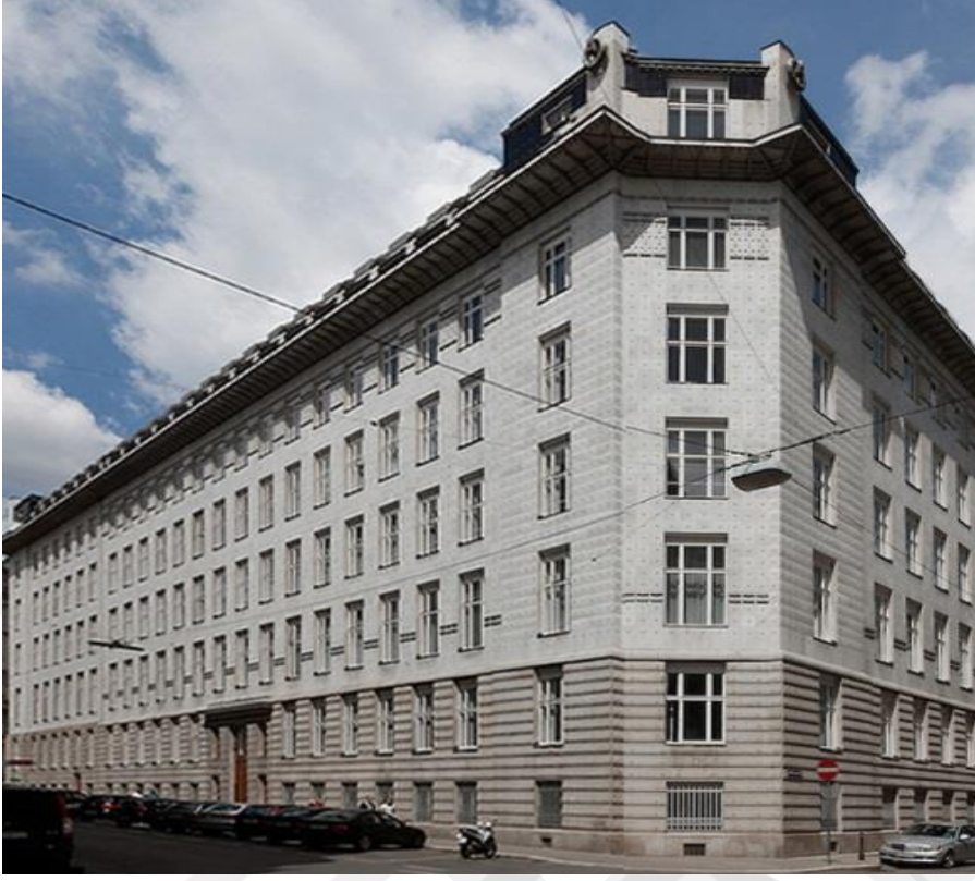
Resim 32. Güney Cephesi Genel Görünüm (Rabia Temel, 2019)
