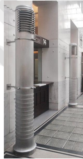
Resim 78. Isıtıcı Yan Görünüş ve Bağlantı Ayrıntısı (Rabia Temel, 2019)
