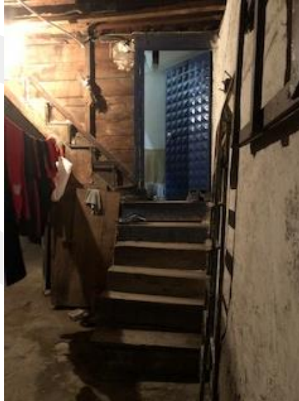
Resim 40: Üst Kata Çıkan Merdiven
