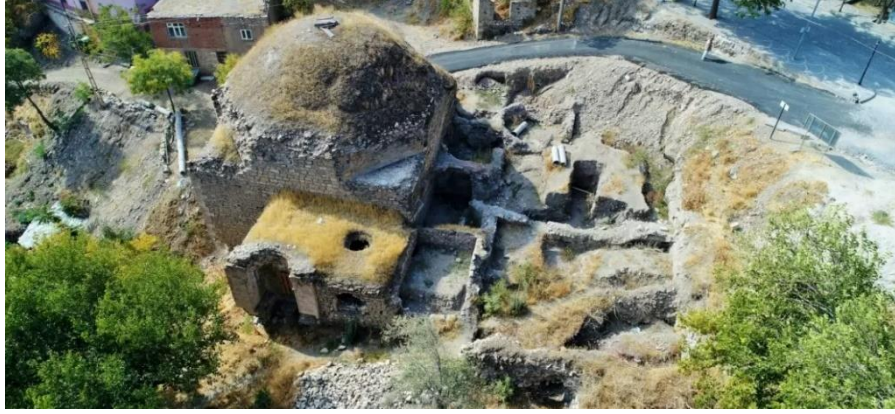
Şekil 39: Hoca Hasan Hamamı (“Tarihi Hoca Hasan Hamamı Restorasyonu Başladı”, n.d.).
