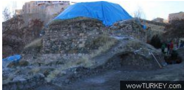
Şekil 40: Harput Kale Hamamı (“Elazığ-Harput-Kale Hamamı”,2015).
