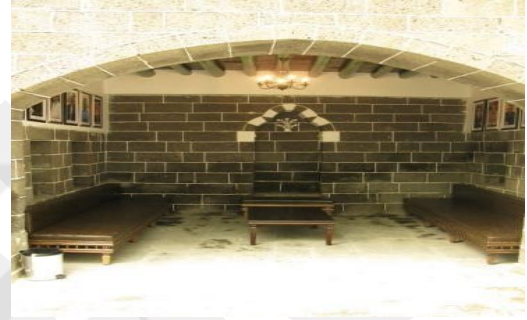
Resim 23 Kemerli eyvan (Yeni 86 )
