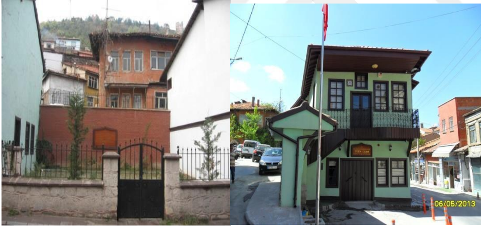
Resim 155 Bina yanındaki bahçe. Resim 156. Bina ve çeşmesi 172
