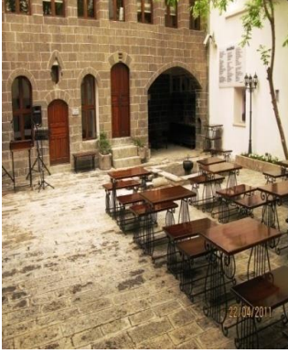
Resim 17 Onarım Sonrası İç Avlu Eyvan Önü
