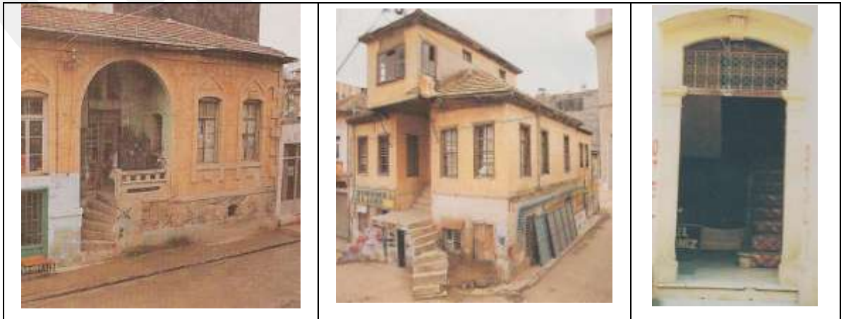
Şekil 48 Mersin Merkezde Geleneksel Konutlarında Merdiven Örnekleri (Renda vd., 1995, s:59,90,107).
