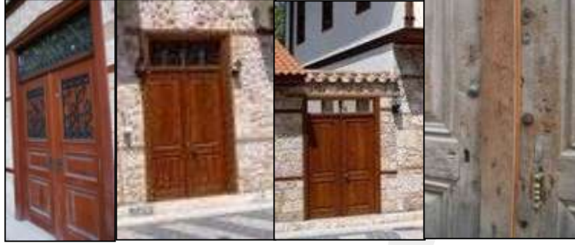
Şekil 73 Antalya Kaleiçi Geleneksel Konutlarında Konut Giriş Kapı Örnekleri, 19.yy. ve 19.yy. Sonu (Buket Güçbey Fotoğraf Arşivi, 2011).
