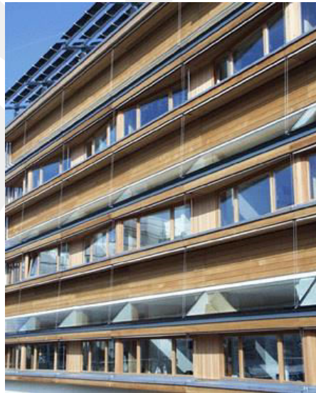
Şekil 18. İsviçre LESO Binası, Anidolik Tavan Örneği (24 Haziran 2014 tarihinde http://leso.epfl.ch/page-43417-en.html adresinden alınmıştır)
