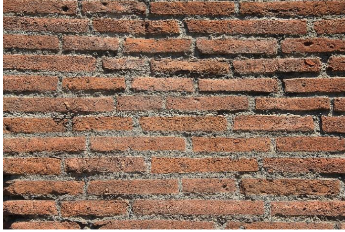
Görsel 9. Tuğlaların Duvarda Oluşturduğu Doku (URL 10)
